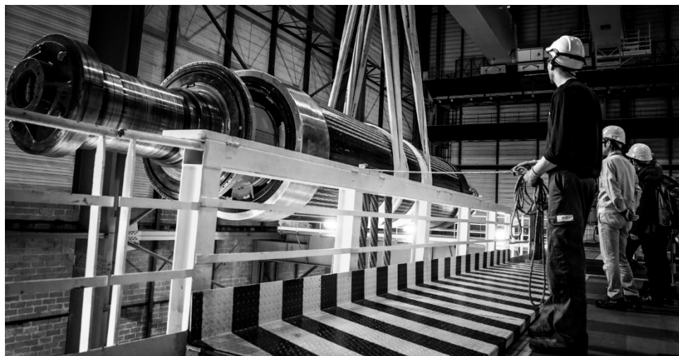
Cliché pris par Jérémy Brancourt, salarié intervenant à la centrale de Cattenom pour la société ARDATEM, pendant l'opération de levage du rotor de l'alternateur sur l'unité n°2.
